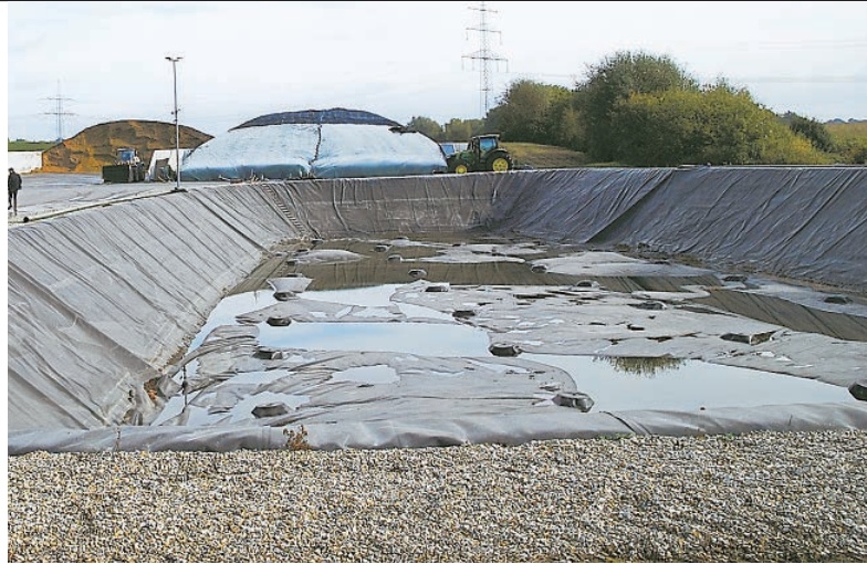
Die Biogasanlage auf Gut Eckendorf wird um eine 5500 m 3 fassende Lagune erweitert. Damit lässt sich der Gärrest über neun Monate lagern. Dazu kommt eine Halle, in der eine Separationsanlage eingerichtet werden soll.
